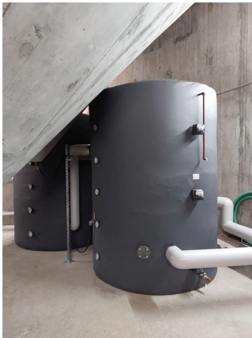
Warmwasserspeicher
