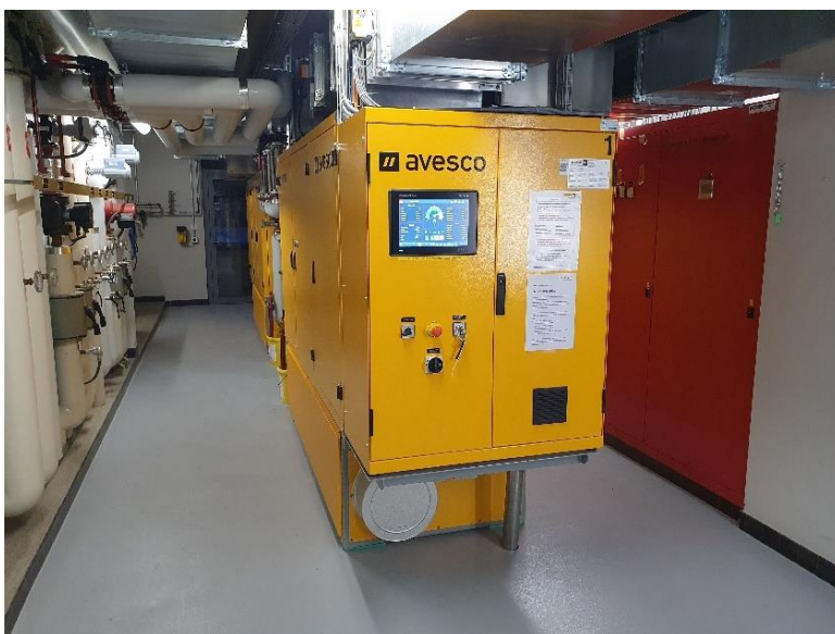
Links BHKW-Aggregate, rechts Wärmespeicher
