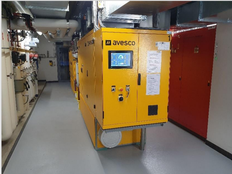
Links BHKW-Aggregate, rechts Wärmespeicher
