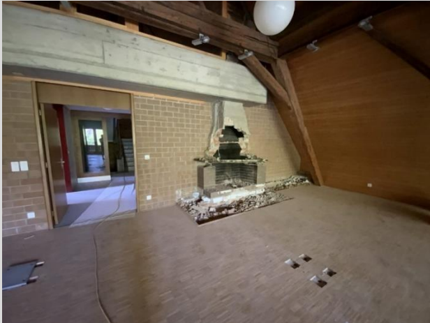
Cheminéeraum vor der Sanierung
