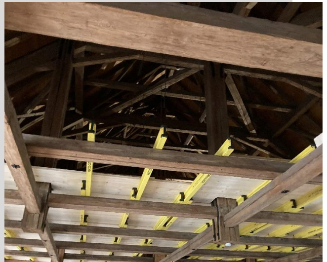
Ausbruch Gemeindesaal (Podest)
