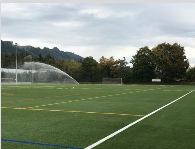
Neues Kunstrasenfeld Nord mit Beregnungsanlage
