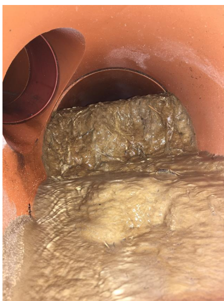
Beispiel Innenansicht Sauberabwasserleitung Bühl vor der Reinigung
