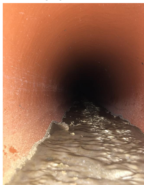
Beispiel Innenansicht Sauberabwasserleitung Bühl vor der Reinigung
