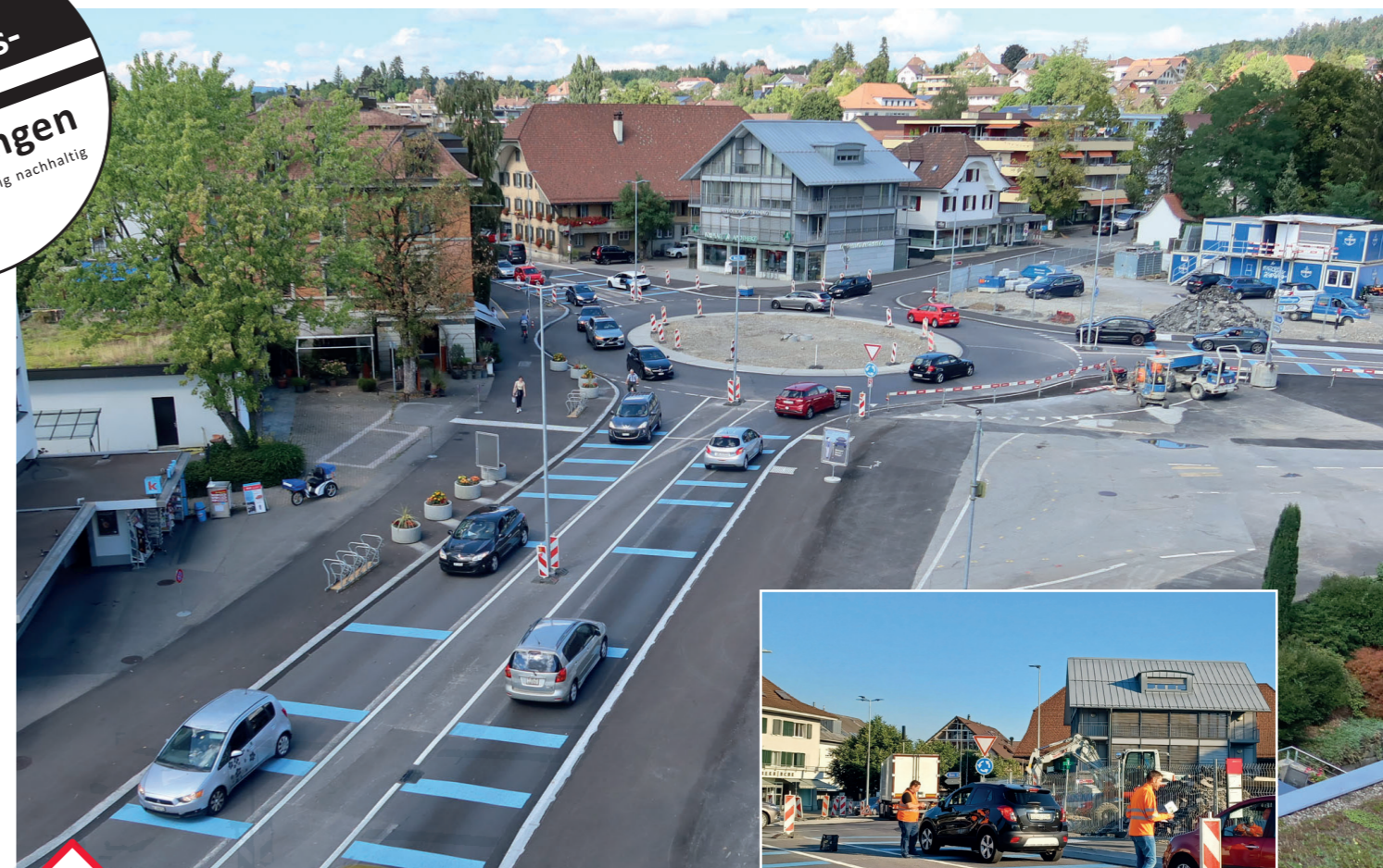
Das neue Verkehrsregime mit Tempo 30 und den blau markierten Querungszonen ist in Betrieb. Im Herbst 2023 werden der Deckbelag, Mittelsinseln und Markierungen fertig gestellt.
