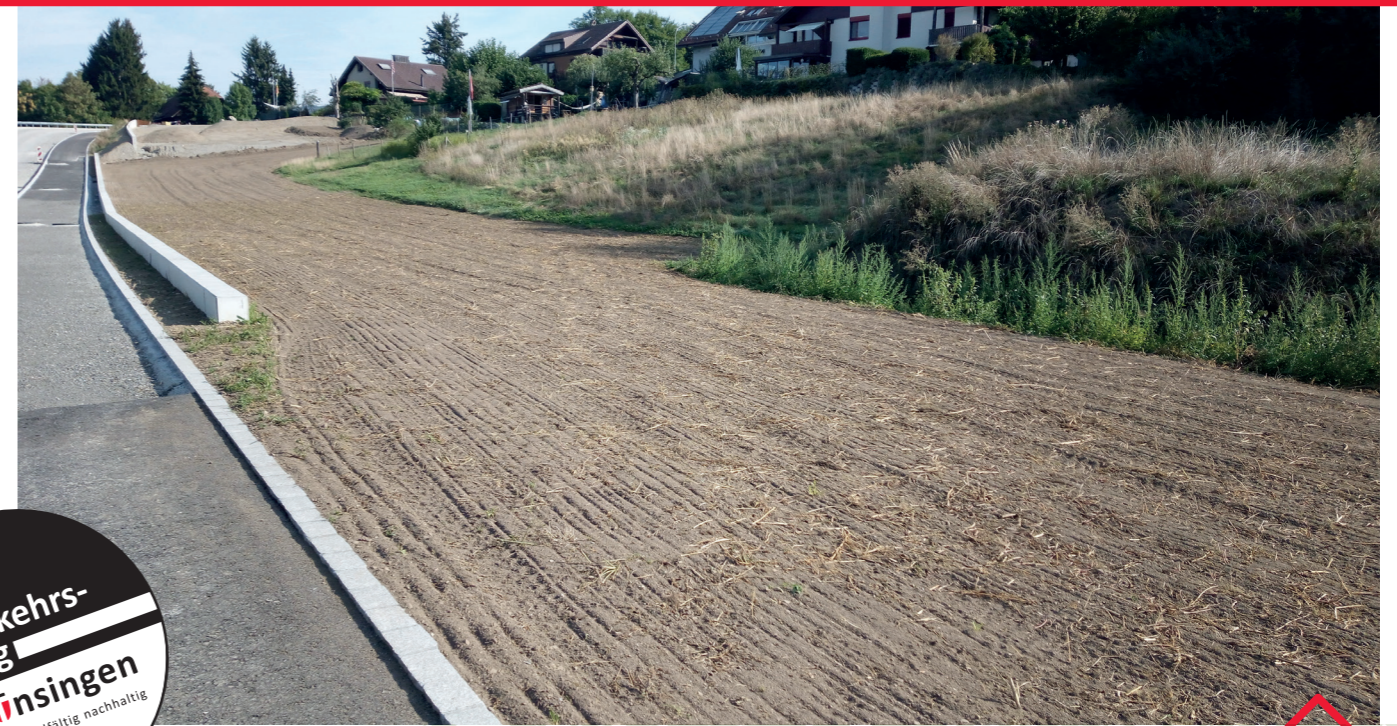
Auf den vorbereiteten Bodenflächen entlang der ESN werden verschiedene ökologische Strukturen angelegt, wie z.B. Einzelbäume, Strauchgruppen, artenreicher Krautsaum, Wurzelstock, Sandwurzstock, Asthaufen. Fotoaufnahme im August 2022.
