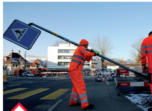
Verkehrsschilder und Wegweiser wurden umplatziert.
