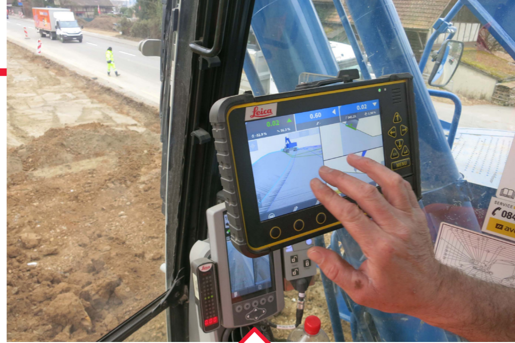
Präzisionsarbeit: Ein GPS-gesteuerter Bagger trägt bei der Ortseinfahrt Nord die Böschung ab.
