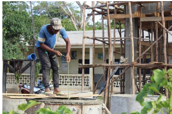
Miasa nutzt Synergien mit anderen Projekten, die Helvetas in der gleichen Gegend umsetzt. So können Jugendliche beispielsweise im Rahmen des von Münsingen unterstützten Wasserprogramms ein Bauhandwerk erlernen.
