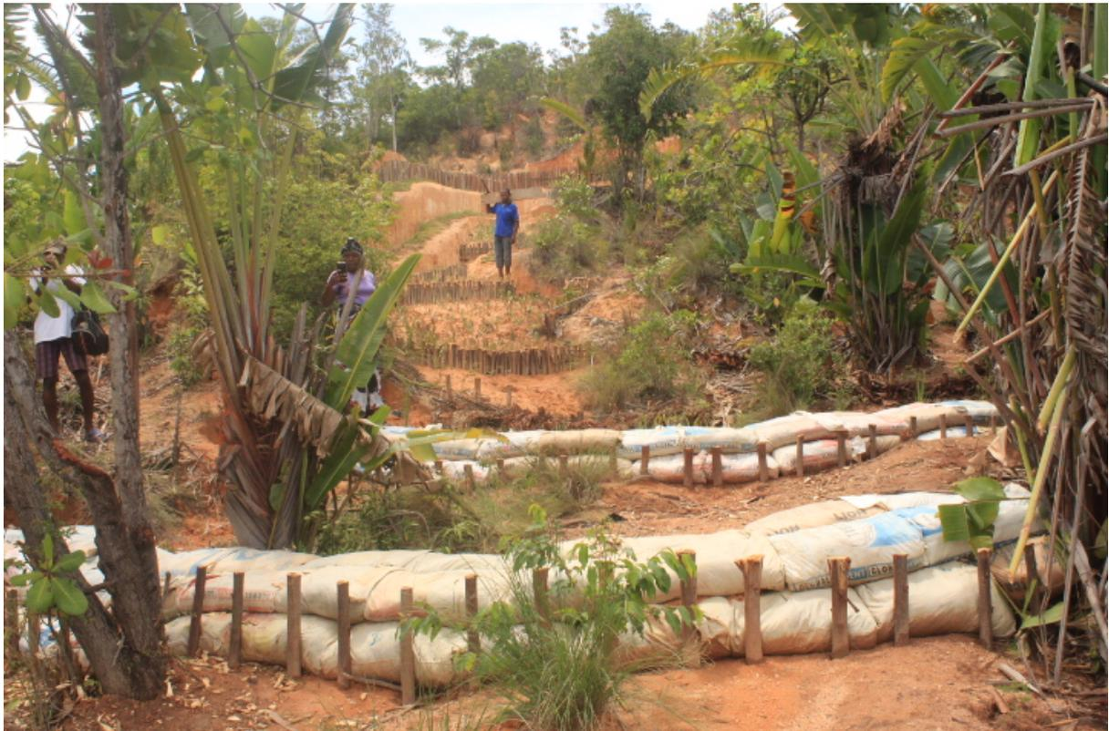
Auch Sandsäcke werden zur Abwehr von Erosionserscheinungen bzw. Böschungsbrüchen gebaut um die Quellen und Wassereinzugsgebiete zu stabilisieren.
