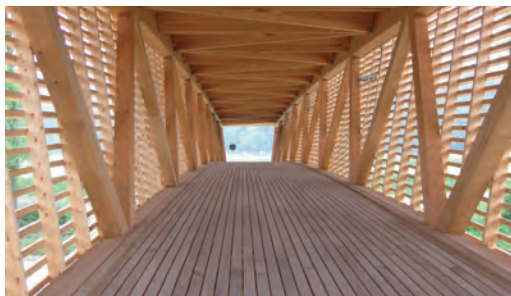
Gedeckter Mittelbereich des Holzstegs
