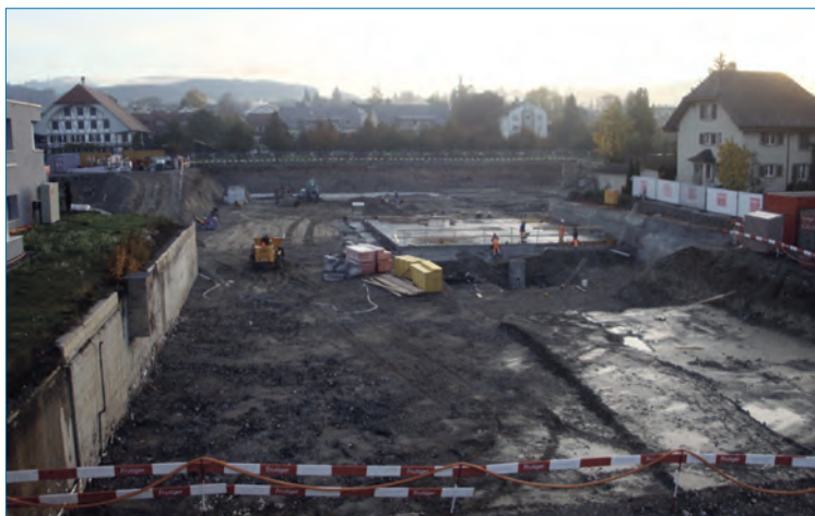
Kranfundament und Baugrube
