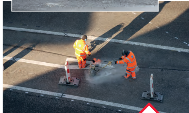
Bestehende Markierungen wurden entfernt und neue Linien aufgetragen.
