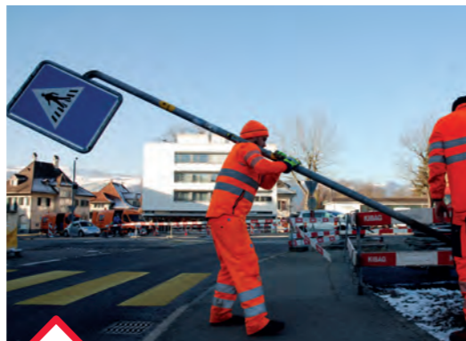
Verkehrsschilder und Wegweiser wurden umplatziert.
