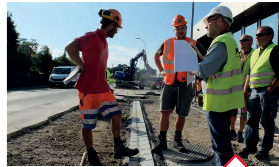
Ein Ingenieur sowie Vertreter der InfraWerke Münsingen und der Baufirma bei der wöchentlichen Begehung vor Ort.
