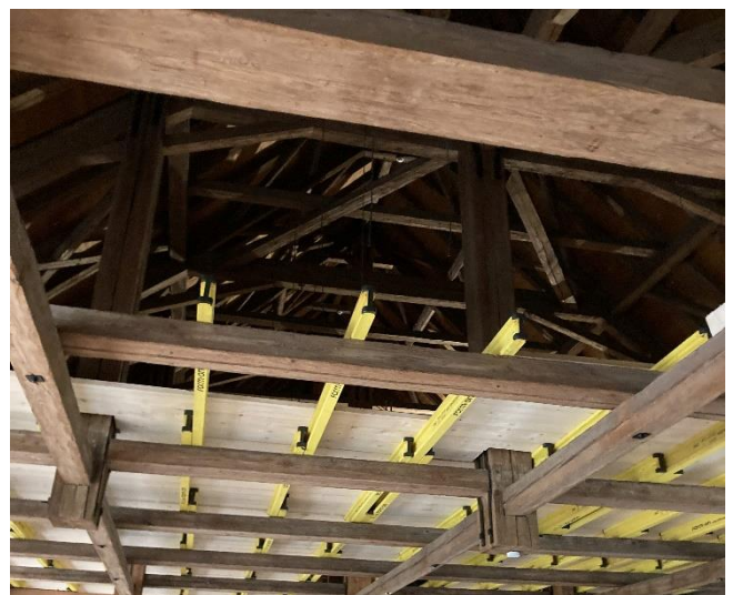
Ausbruch Gemeindesaal (Podest)
