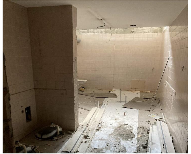
Ausbruch Sanitäranlage
